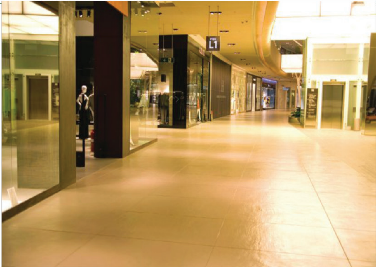
Para o assentamento do quartzo Wave Cancun foi utilizada massa flexível C3 (Bellinzoni), com junta de 5 mm Setting was made with C3 flexible mortar (Bellinzoni) and 5-mm joints
